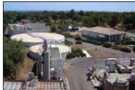
La station d'épuration intercommunale de Cavalaire et La Croix-Valmer
