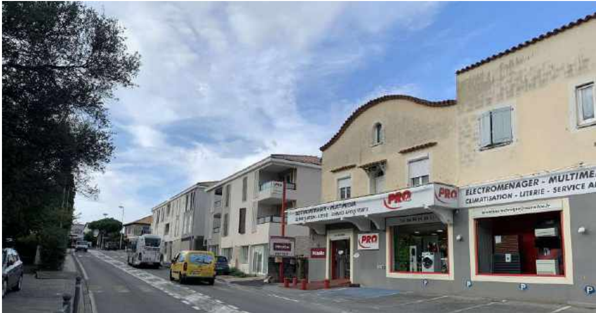
L'opération en cours de livraison, en entrée de ville Nord, le long de la RD559
