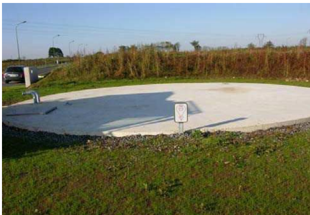
Réserve d'eau enterrée
