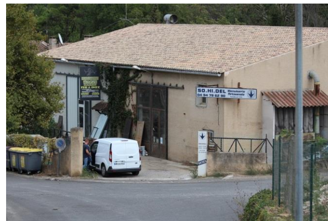
Enseigne sur façade – Non conforme car elle-n'est pas apposée à plat sur le mur et la saillie est supérieure au 25 centimètres règlementaires.
