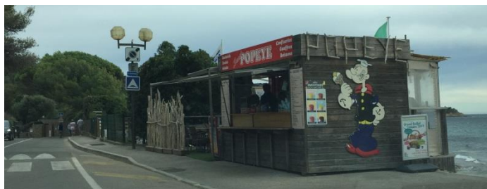
Enseigne en façade - Conforme
