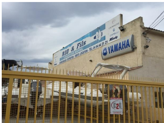
Enseigne sur façade - Conforme car ne dépasse pas les limites du mur de la façade et taille inférieure à 25% de la façade.
