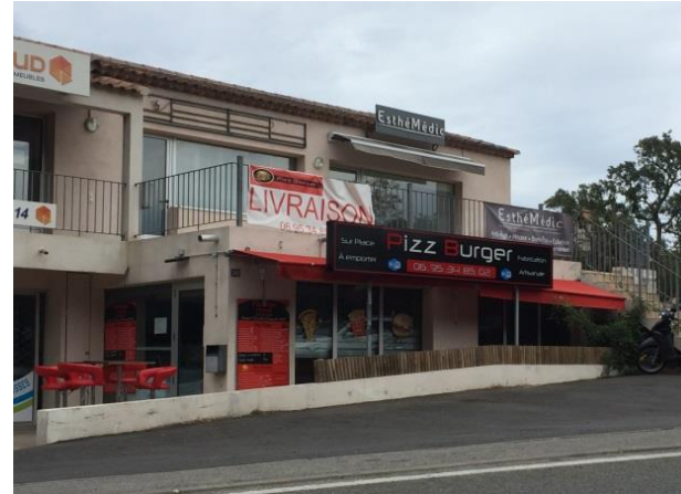
Enseigne murale visible depuis la RD559 - Non-conforme à la réglementation nationale - Dépasse les limites du mur de la façade (Esthémédic) et saillie trop importante (supérieure à 25 centimètres) pour Pizz Burger.
