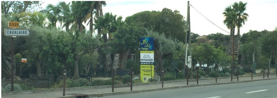
Enseignes au sol, en bordure de voie (sur l'unité foncière du bâtiment d'activité concerné) – Conforme à la RNP
