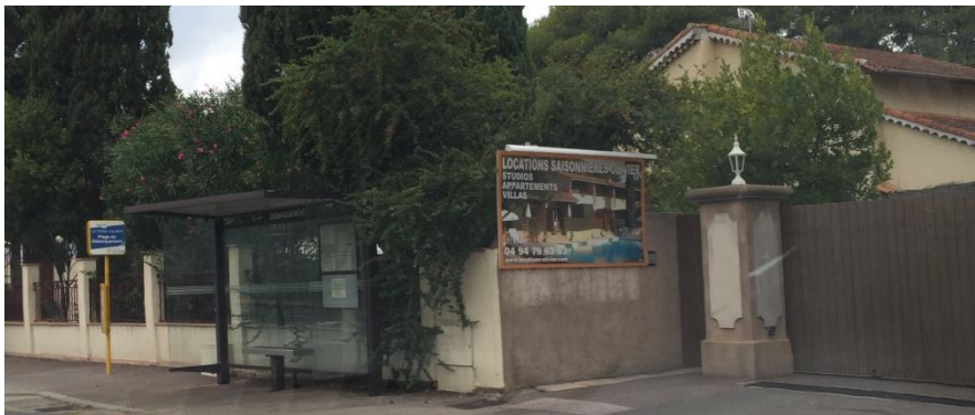
Préenseigne scellée en façade – Non conforme au regard de l’adhésion à la charte du PN de Port-Cros et dépasse la hauteur du mûr
