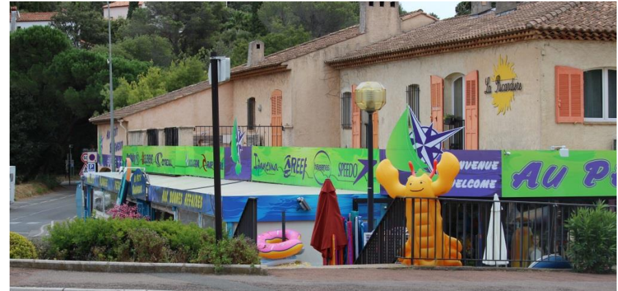
Enseigne à plat sur balcon – Non conforme en partie car supérieure à 1m de haut et dépassant la hauteur du garde-corps
