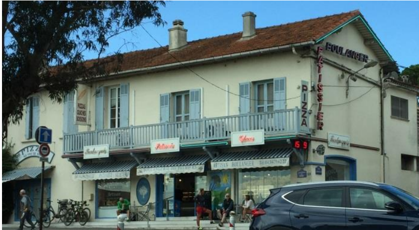
Enseigne scellée en façade ou sur store – Conforme à la RNP. Enseigne lumineuse qui dépasse la hauteur de l'égout du toit – Non conforme à la RNP
