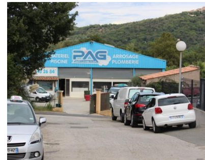
Enseigne sur façade – Non conforme car elle dépasse les limites de l'égoût du toit.
