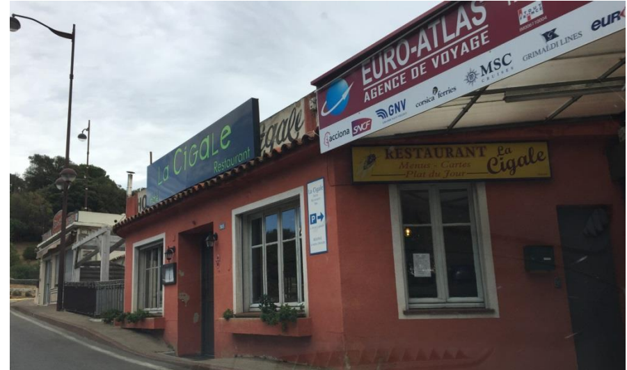
Enseigne sur toiture (La cigale) – Non conforme à la RNP, les lettres doivent être découpées et sans fixations visibles
