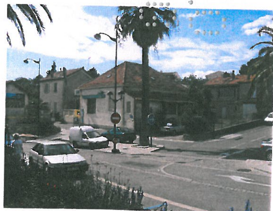
Vue de l'îlot particulier du centre urbain, zone UAa
