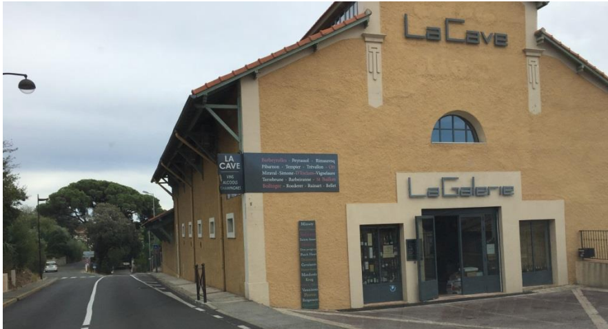
Enseigne scellée en façade – Conforme – Qualité de l'enseigne avec lettres découpées
