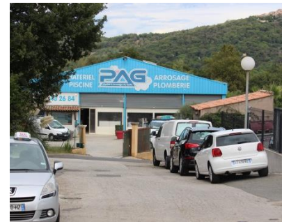
Enseigne sur façade – Non conforme car elle dépasse les limites de l'égoût du toit.
