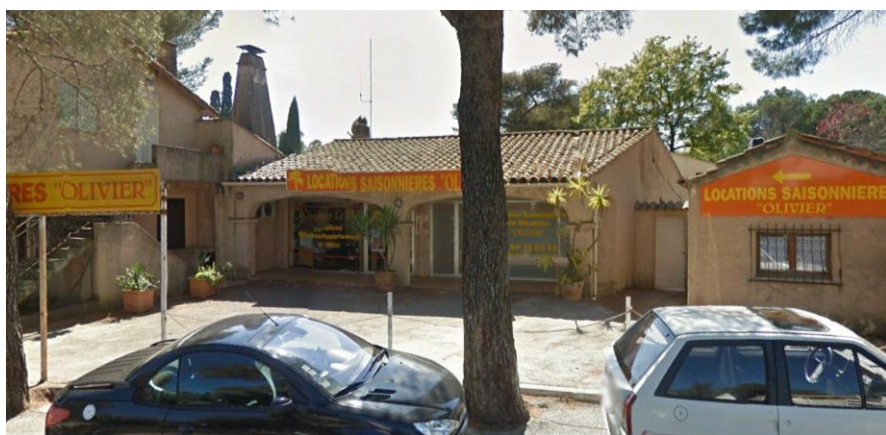
Enseigne en façade qui dépasse les limites du mur sur laquelle elle est apposée – Non conforme à la RNP
