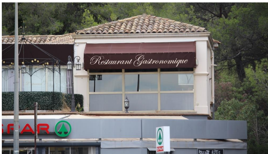
Enseigne scellée en façade ou sur store.
