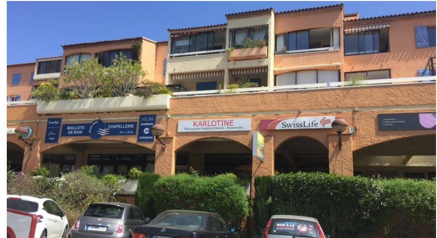
Immeuble Odyssee, une architecture spécifique qui rend plus difficile l'intégration architecturale des enseignes.
