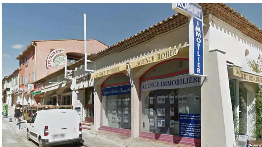
Enseigne scellée en façade ou sur store – Conforme à la RNP. Enseigne en drapeau qui dépasse la limite supérieure du mur – Non conforme à la RNP
