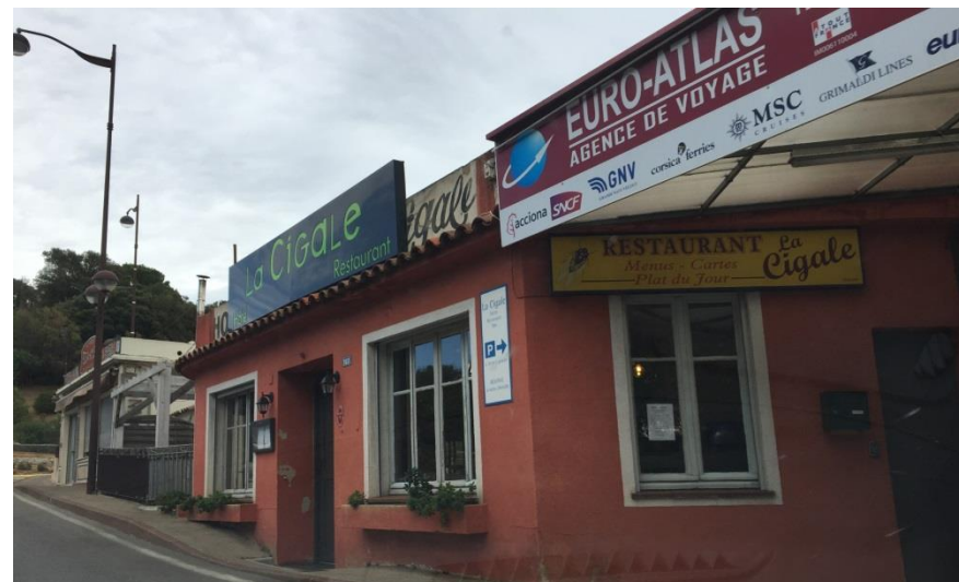
Enseigne sur toiture (La cigale) – Non conforme à la RNP, les lettres doivent être découpées et sans fixations visibles
