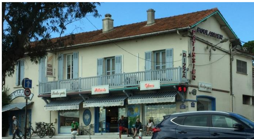
Enseigne scellée en façade ou sur store – Conforme à la RNP. Enseigne lumineuse qui dépasse la hauteur de l'égout du toit – Non conforme à la RNP
