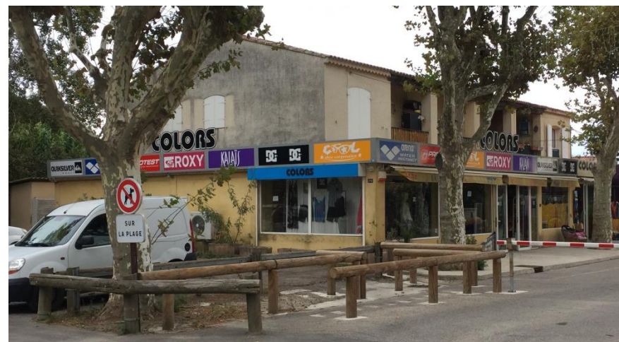
Enseigne en façade sur balconnets – Conforme à la RNP car la hauteur ne dépasse pas 1 m et ne s'élève pas au dessus du garde-corps
