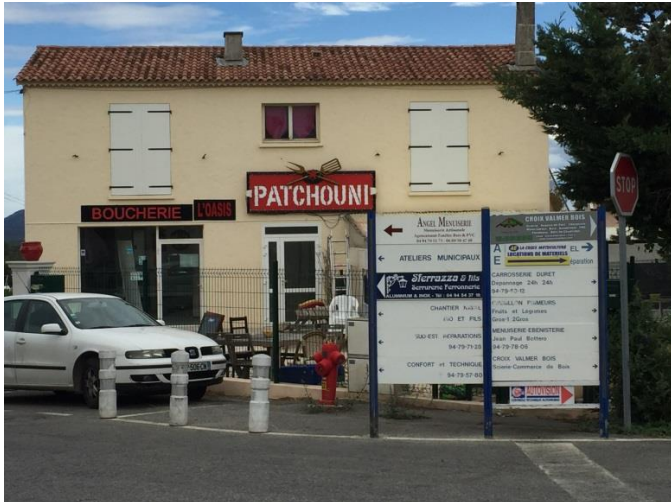
Enseigne mural visible depuis la RD559 – Conforme à la réglementation nationale si inférieure à 25% de la devanture commerciale.
