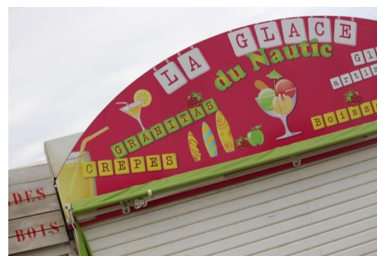
Enseigne en façade qui dépasse les limites du mur sur laquelle elle est apposée – Non conforme à la RNP
