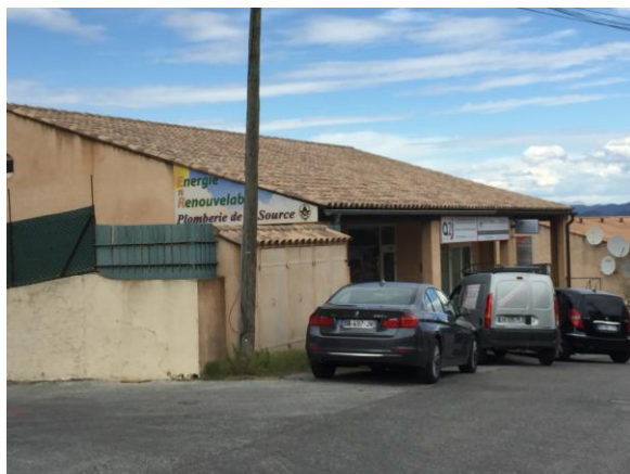
Enseigne sur façade – Non conforme car celle-ci dépasse les limites de l'égout du toit.
